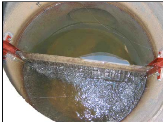
Utloppsbrunnen vid övre dammen. Utloppströskelns nivå kan regleras med hjälp av plankor i utloppsbrunnen.
