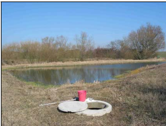
Utloppsbrunnen vid övre dammen. Utloppströskelns nivå kan regleras med hjälp av plankor i utloppsbrunnen.
