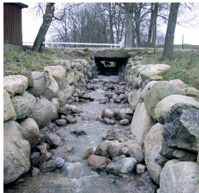
Ett vandringshinder har här byggts bort genom iläggning av stentrösklar nedströms hindret.
