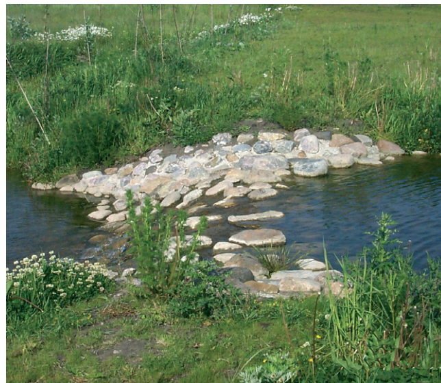
Exempel på ett betongdämme med ingjutna naturstenar.
