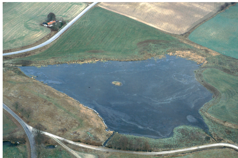
Vid Stridsmölla i Segeåns avrinningsområde intill Hybybackar har en kvarndamm återskapats. Dammen har en areal på 2,6 ha och har genom fördelaktiga höjdförhållanden kunnat anläggas med en kombination av dämning och schaktning. På så vis har schaktinsatserna kunnat begränsas.
