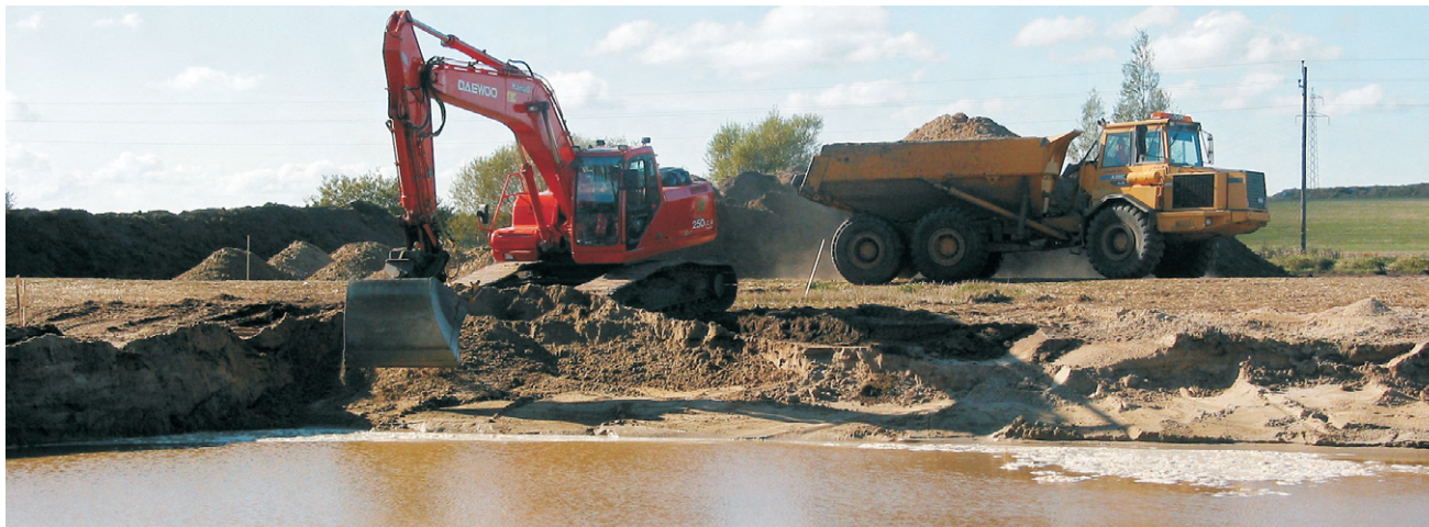
Schaktarbeten vid ett dammbygge i Holmby, Eslövs kommun. Transporten av schaktmassorna över fälten med dumper skall ske som här vid torra förhållanden för att undvika körskador.
