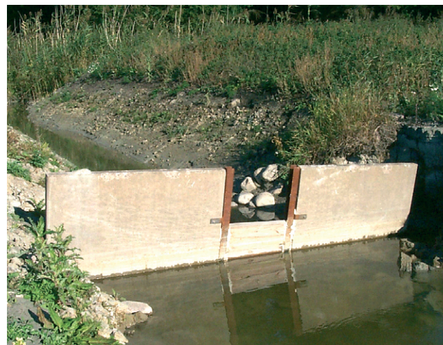
Om ett dämme inte byggs in tillräckligt långt i dammvallen och erosionsskyddas ordenligt är det lätt hänt att vattnet eroderar bort jorden vid sidan av
