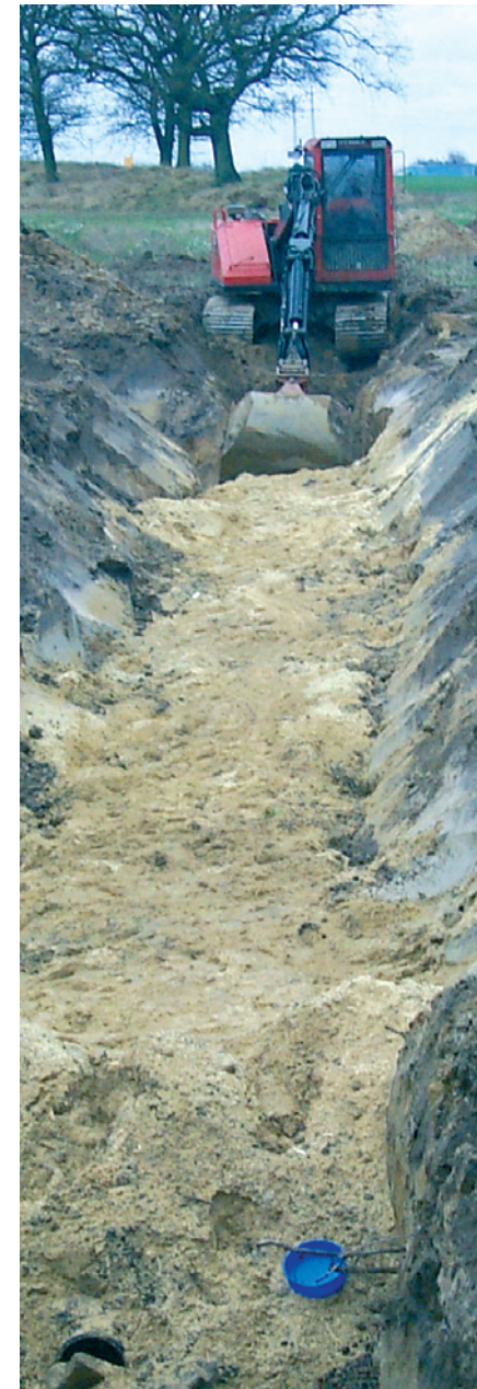
Grävningsarbeten i samband med byggandet av en kvävmur.
