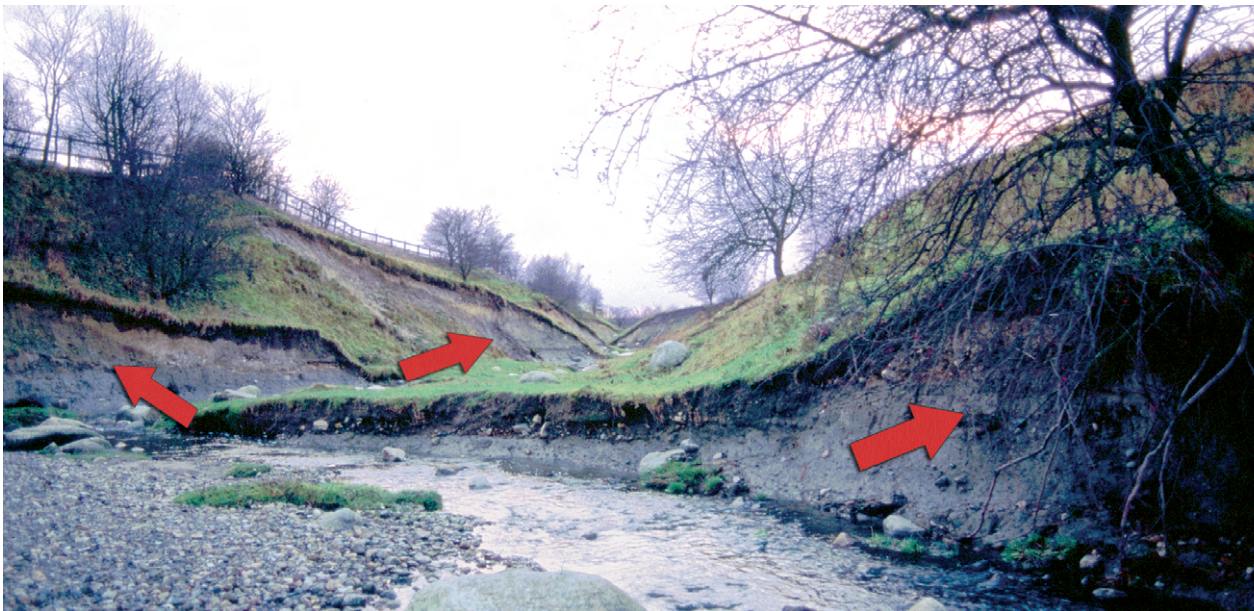
Erosion i strandbrink (pilar).
